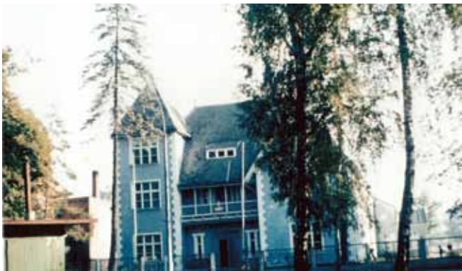
Budynek główny (1969 r.), zdjęcie pochodzi ze zbiorów Roalda Maniewskiego.
